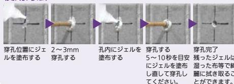
穿孔位置にジェルを塗布する → 2~3mm 穿孔する → 孔内にジェルを塗布する → 穿孔する 5~10秒を目安にジェルを塗布し直して穿孔してください。 → 穿孔完了 残ったジェルは濡った布等で綺麗に拭き取ることができます。
